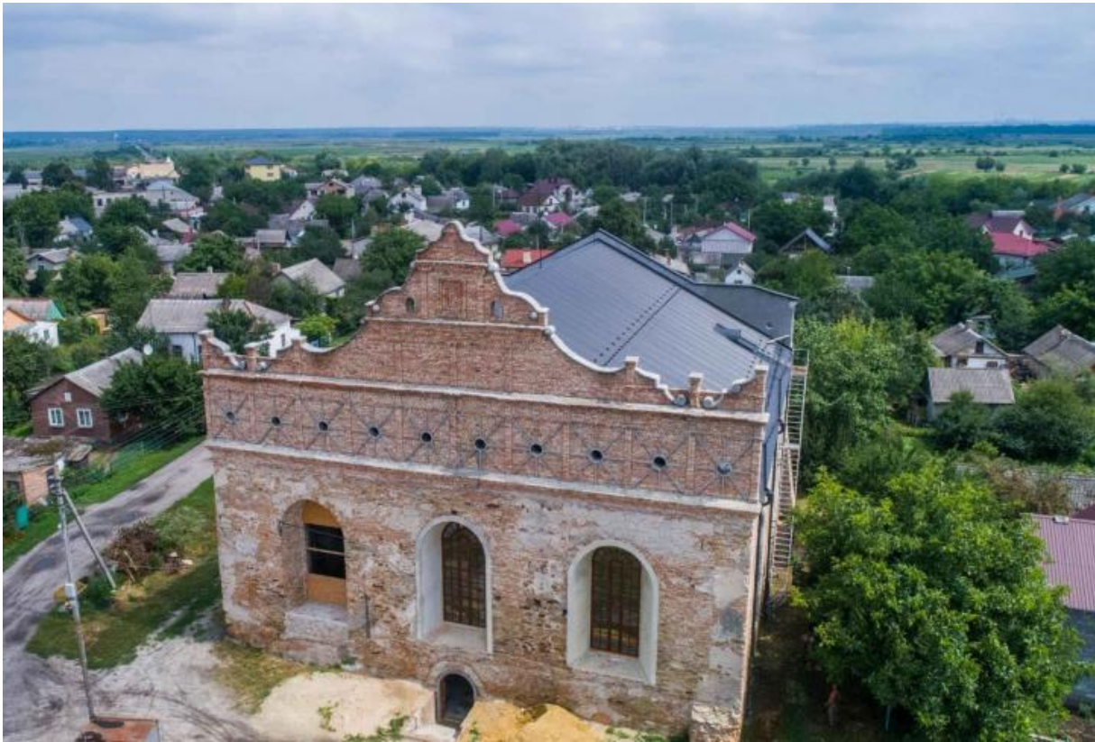
Синагога Острога у процесі реконструкції
